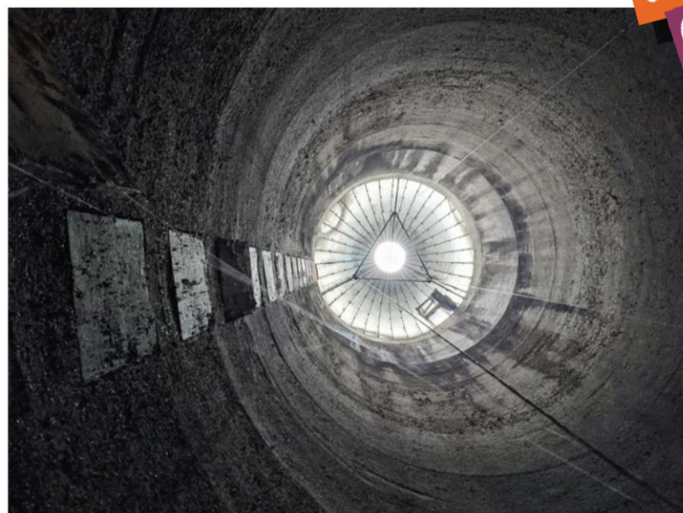
Intérieur d'un silo
